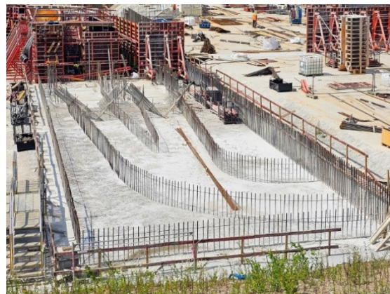
Foto 12 Complexe vorm van het omloopriool vroeg om bijzondere aandacht voor de bekisting
