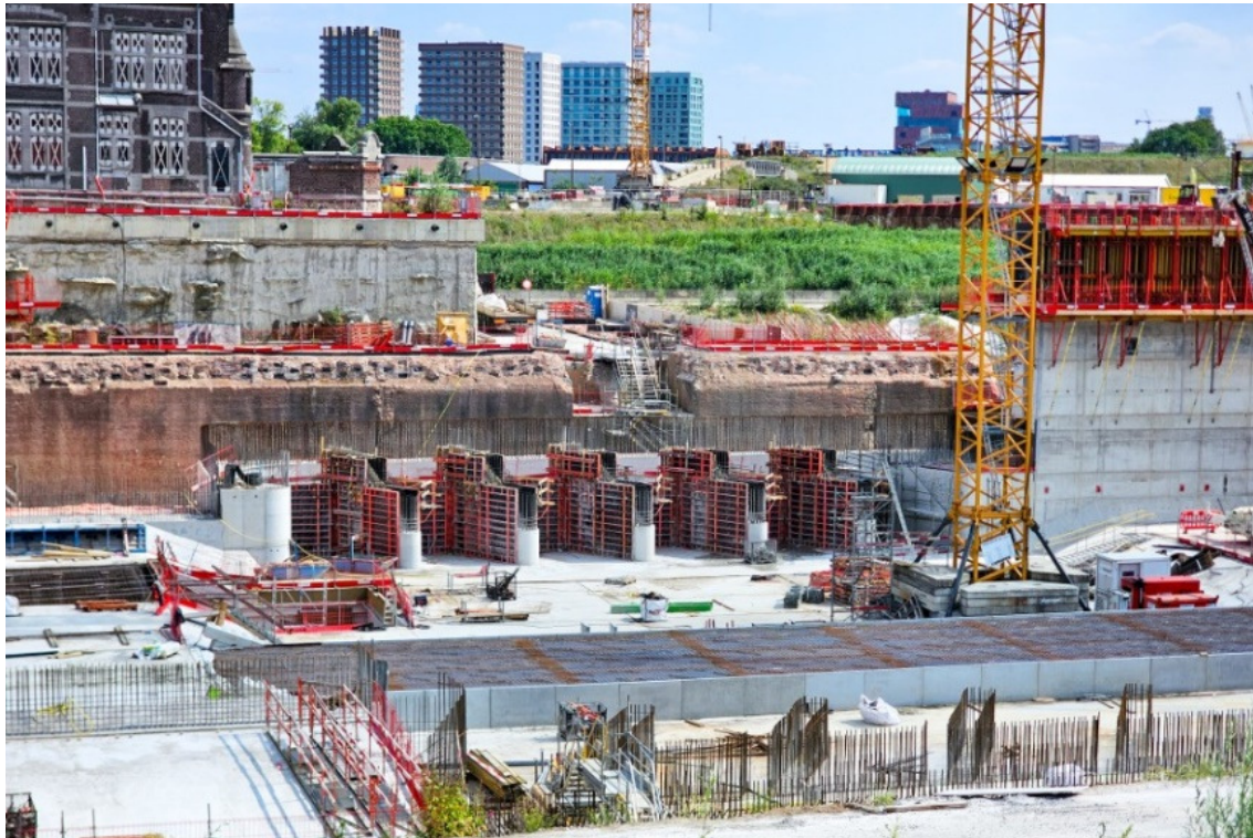
Foto 11 Bouw van de uitstroom van het omloopriool
