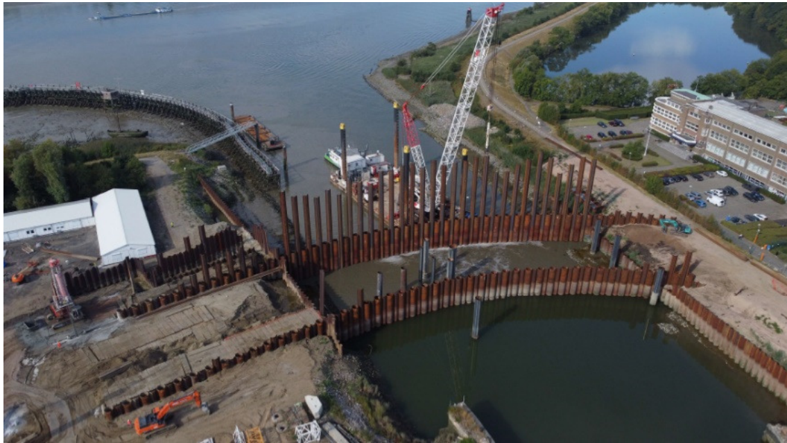
Foto 7 Kofferdam benedenhoofd in aanbouw (foto: Rinkoniën)
