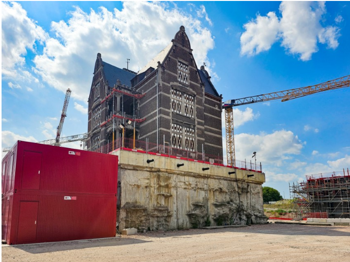
Foto 6 Sluismeesterswoning op een 'eiland' omsloten met diepwanden
