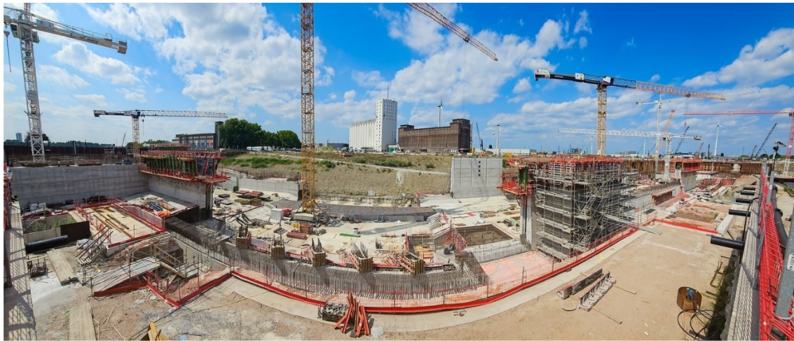
Foto 1 Overzicht van de bouwput van de Royerssluis
