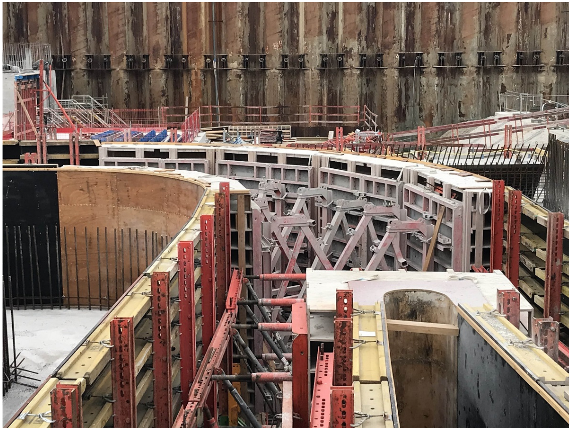
Foto 16 De omloopriolen zijn uitgevoerd met een dragerbekisting in combinatie met vuldozen (foto: Rinkoniën)
