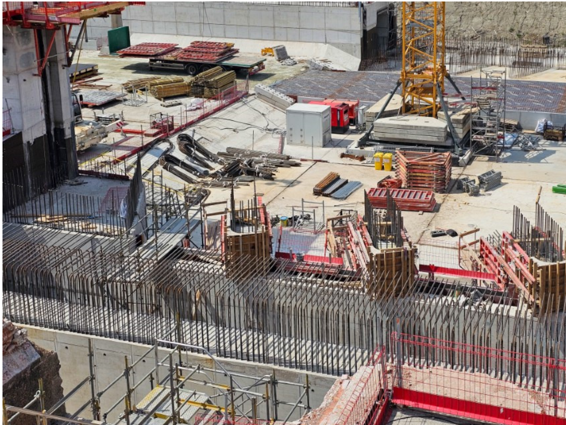
Foto 10 Fragment van de bouwput met in het midden de vloerplaten zichtbaar
