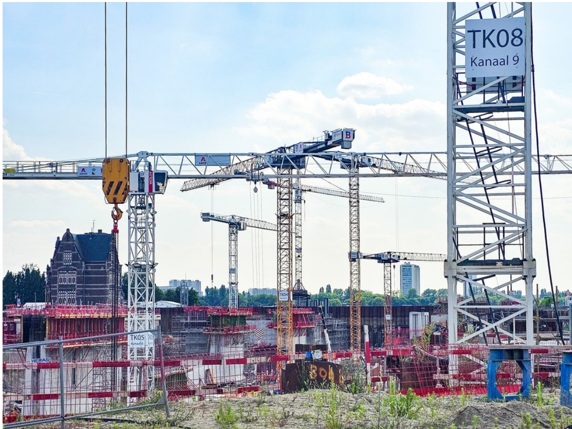
Foto 22 Bouwplaats met acht torenkranen
