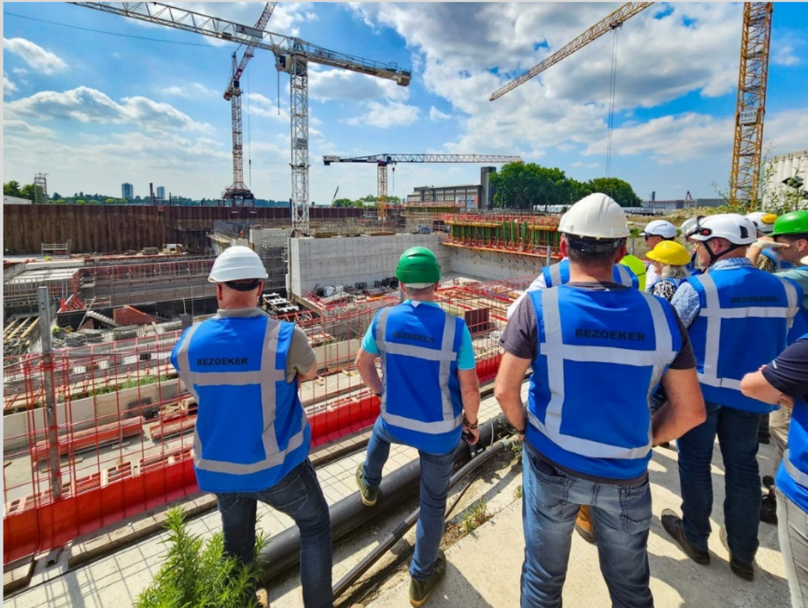
Foto 2 Stubeco-leden bekijken de werkzaamheden aan de Royerssluis
